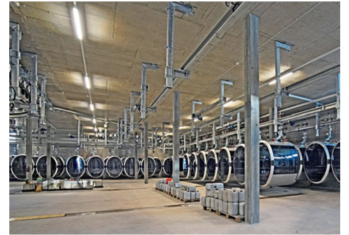
Die teilautomatische Fahrzeug-Garagierung in der Talstation Tannenboden ermöglicht auch bei Vollbestückung mit allen 105 8er-Gondeln schnelle Einstellzeiten von 20 – 25 Minuten.
