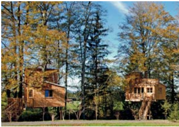
Die insgesamt vier Häuser des „Baumhaushotel Allgäu“ hängen an Stahlseilen fixiert, frei in den Bäumen. Foto: Baumhaushotel Allgäu
