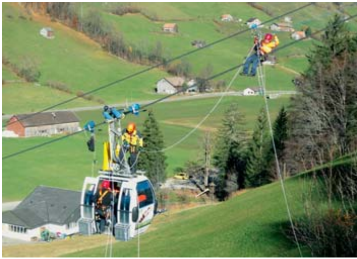
Mit speziellem Material können die Passagiere entlang dem Bahnseil verschoben werden.
