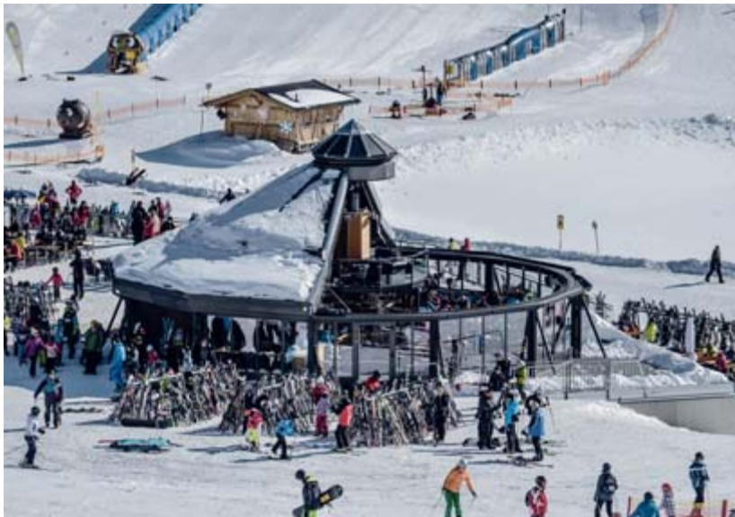
Auf Knopfdruck lässt sich die Hälfte des Daches jederzeit einfahren.
