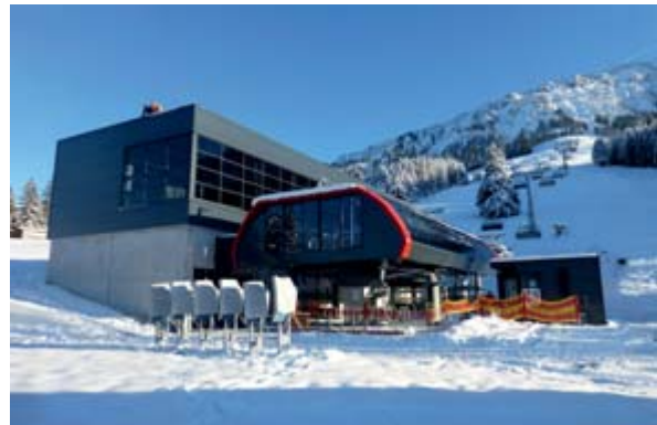
Blick auf die Talstation der neuen Grenzriesbahn.
