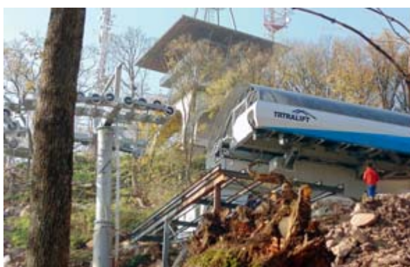
Die Bergstation entsteht.
