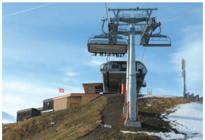
Die neue Bergstation wurde direkt an das Bergrestaurant angeschlossen. Der Stationsbau (helles Holz) des ehemaligen fixen Zweiersessels beherbergt jetzt die Elektrotechnik des Bahnantriebs.
