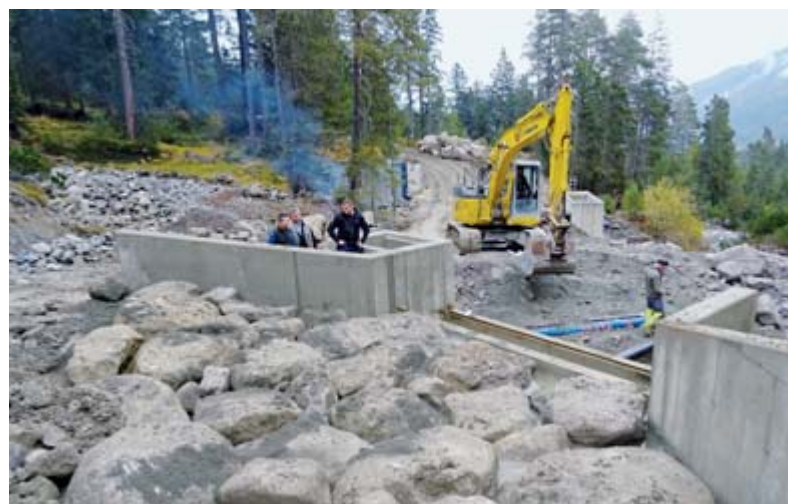
Anlegen einer neuen Wasserfassung.
