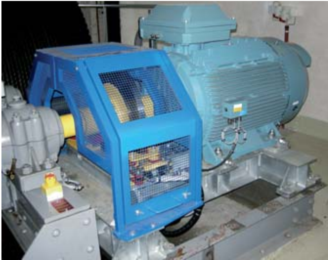
Ein ABB Motor 110 kW mit Temperaturüberwachung, wurde an das bestehende Von Roll Getriebe in der Bergstation eingebaut.
