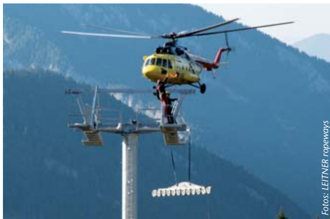
Stützen werden mit Helikopterhilfe gesetzt.
