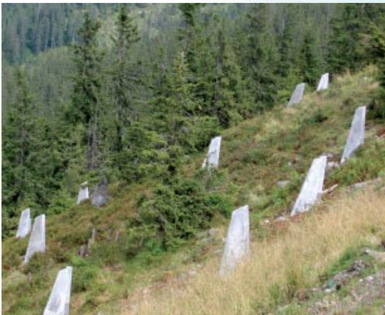
Snowgripper-Verbauung der Karalmlawine. Fotos: Snowgripper
