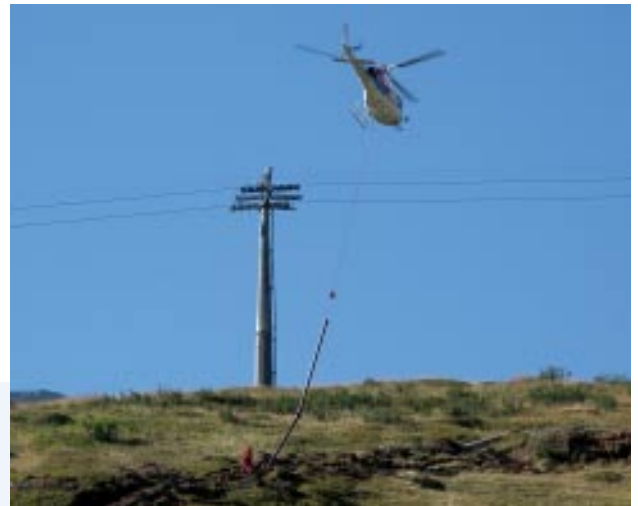
Bei der Montage der Schneileitung wurden Hubschrauber eingesetzt.
