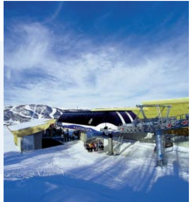
Die Talstation auf 925 m Seehöhe wurde mit der hohen Stationsüberdachung versehen.
