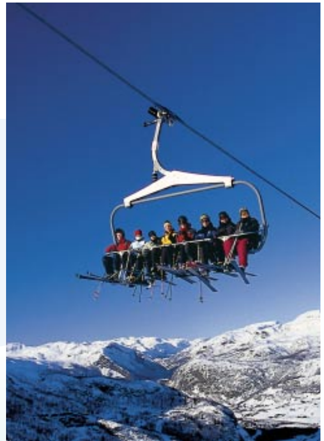
Die neue 8er-Sesselbahn bietet Leistung und Komfort.
