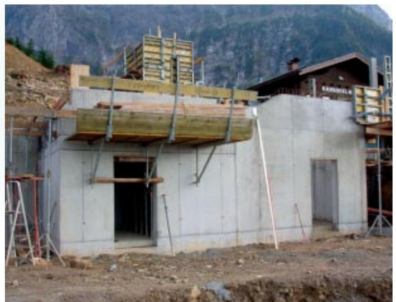
Die Arbeiten am Berg schreiten zügig voran. Foto: BB Abtenau
