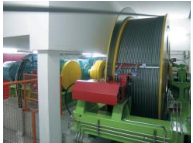
Der Antrieb wurde in der Bergstation positioniert.
