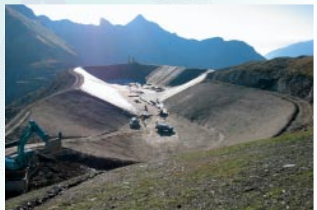
Einsatz von HUESKER-Geokunststoffen beim Speicherteich „Zehnerkar“. Fotos: HUESKER
