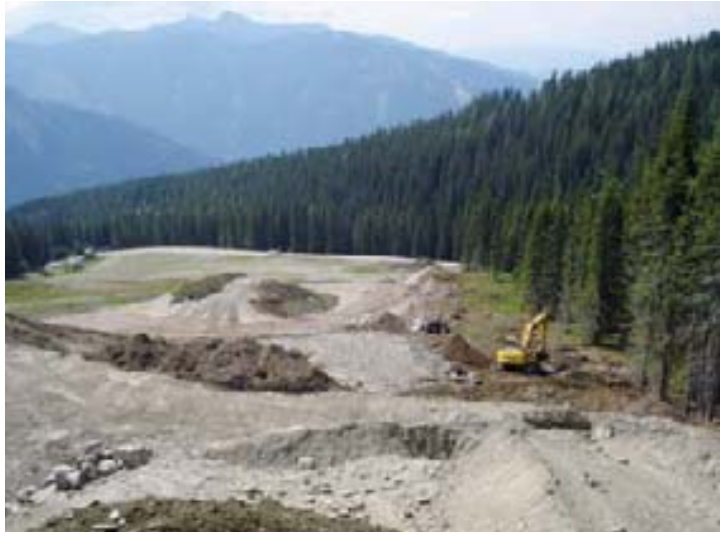
Erdbaumaßnahmen im Funpark reduzieren den Schneeverbrauch.
