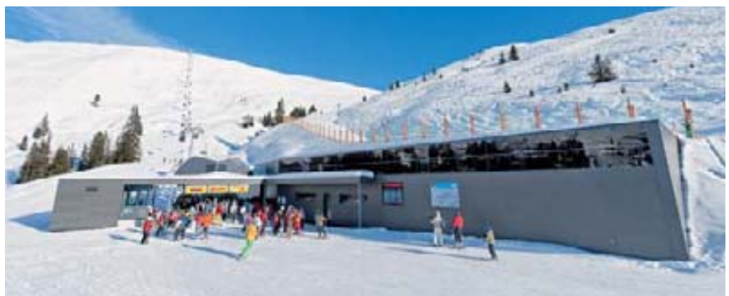
Mit 50 8er-Kabinen von CWA bringt die Falschbachbahn 2 800 P/h auf den Berg.
