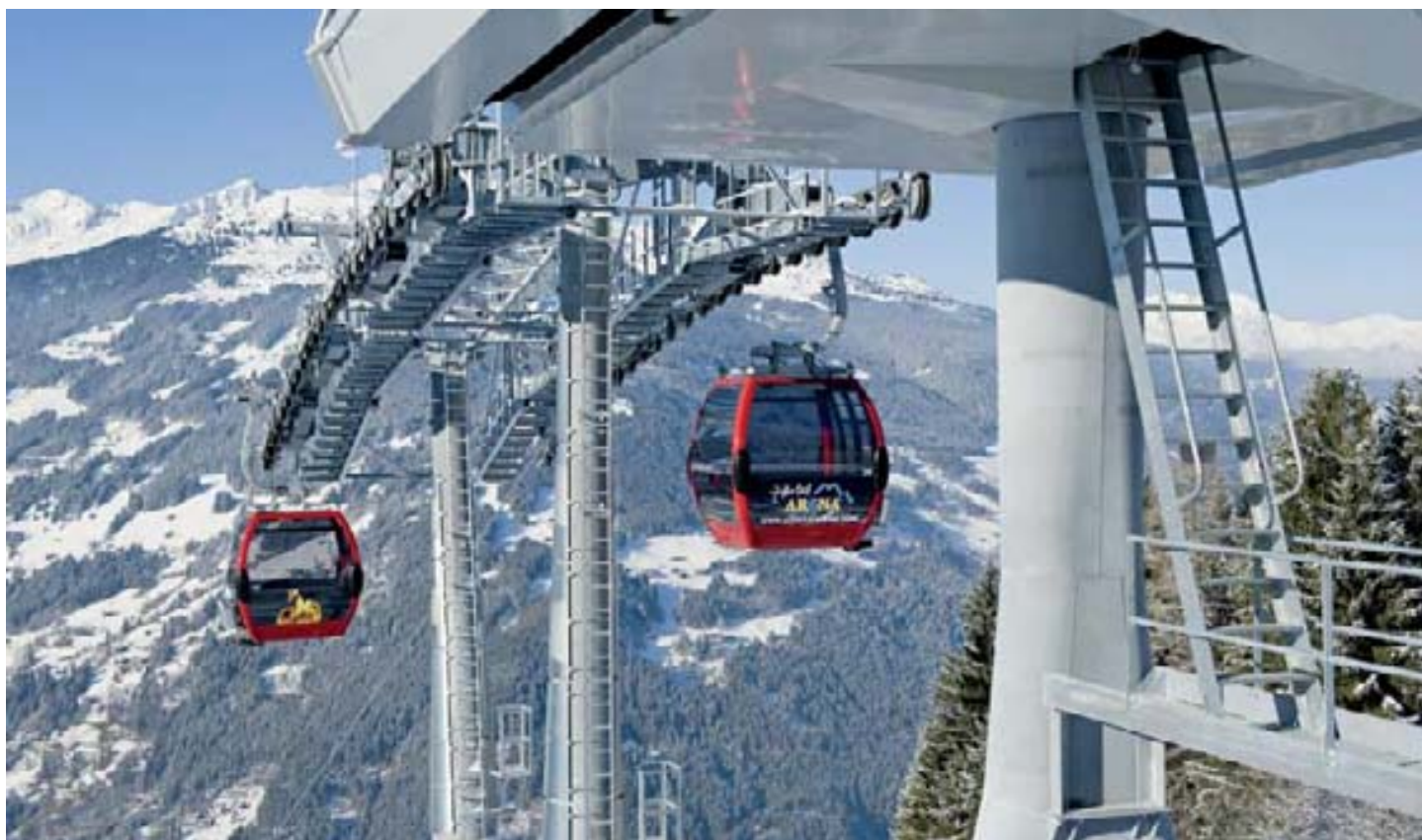
8 EUB Karspitzbahn II. Fotos: Zillertal Arena
