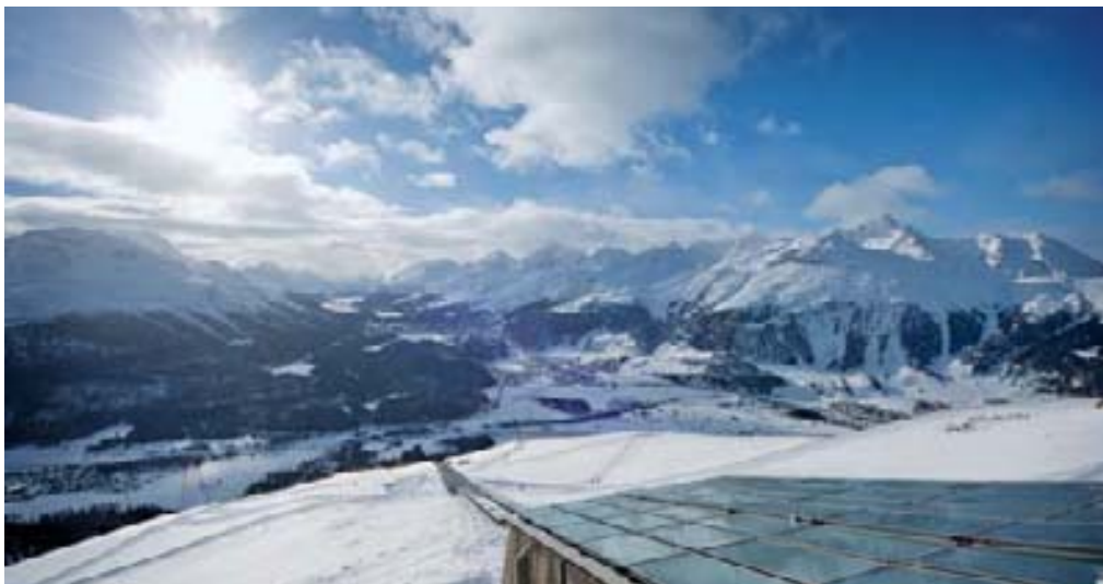
Die großflächigen Flachkollektoren schaufeln 50 000 kWh/Jahr Solarwärme ins Haus.
