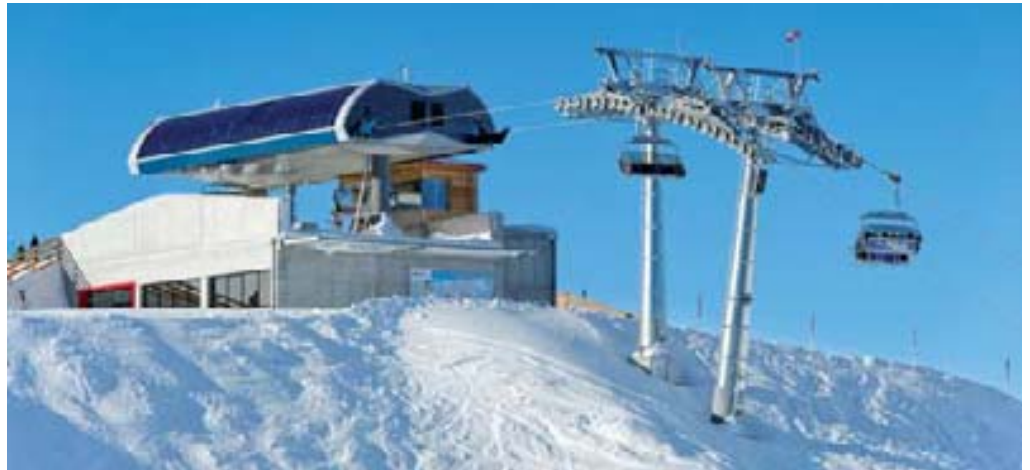
In der Bergstation wurde der Antrieb platziert.
