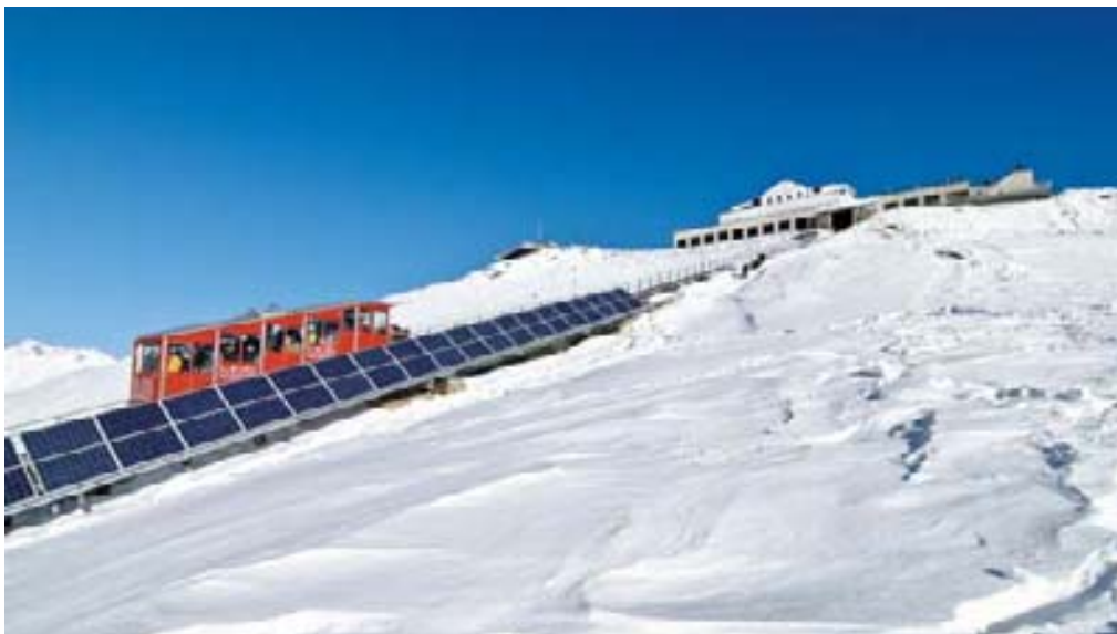
Photovoltaik-Paneele entlang der Bahntrasse erzeugen 100 000 kWh Strom/Jahr.
