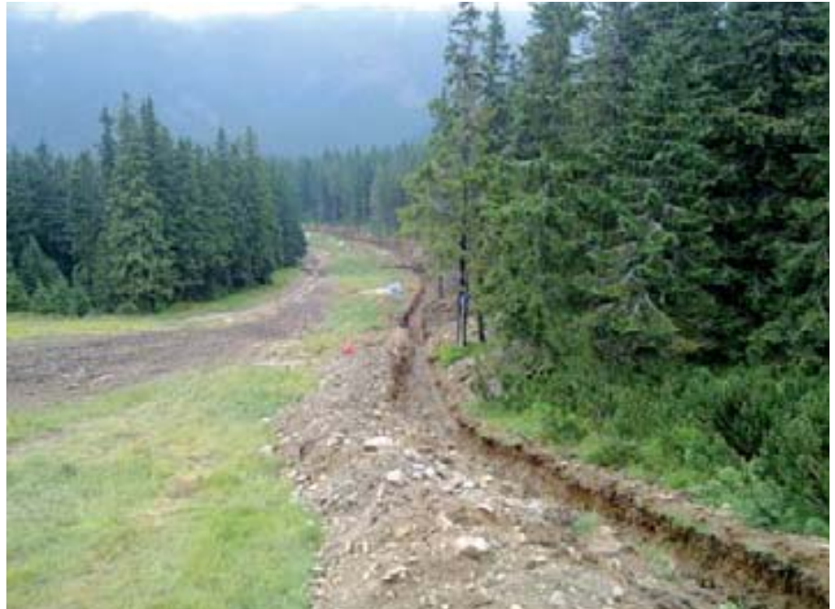
Baustelle Beschneigungsanlage Skigebiet Jasna. Fotos: JCN
