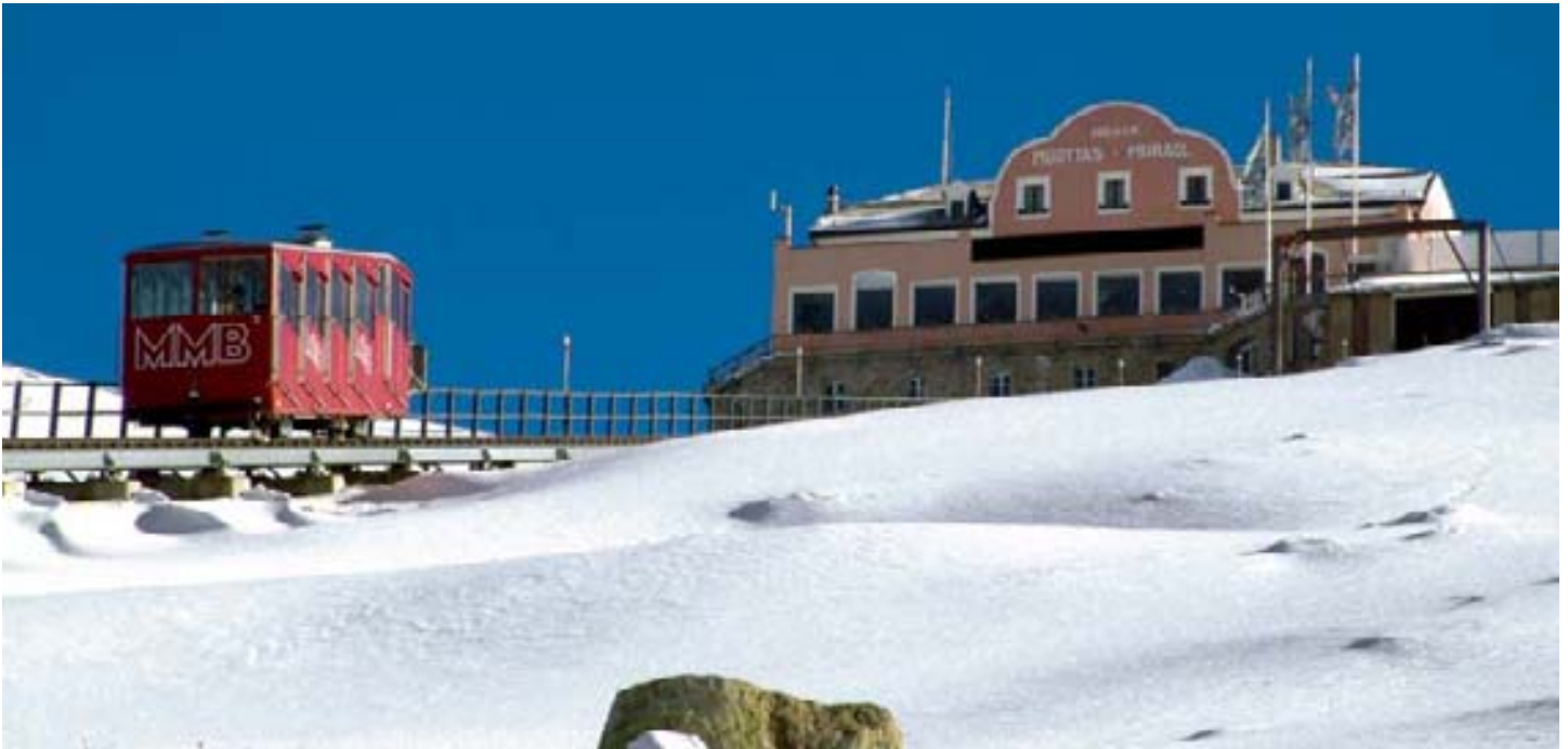
Das Hotel Muottas Muragl der BB Engadin St. Moritz AG wurde zum ersten Plusenergie-Hotel der Alpen umgebaut. Fotos: BEST
