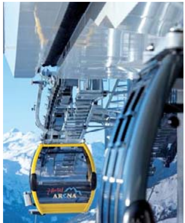
Die Talstation der 8 EUB Falschbach wurde auf 1 868 m Seehöhe gebaut.
