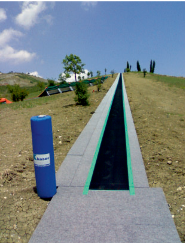
Fertige Montage eines skicarpets. Fotos: Kaser
