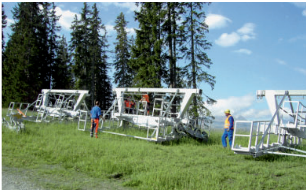
Die Anhängervorrichtungen werden montiert. Fotos: dwl
