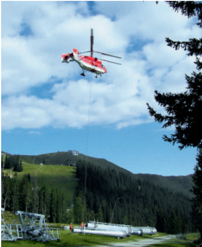
Eine Stütze wird am Helikopter eingeklinkt ...
