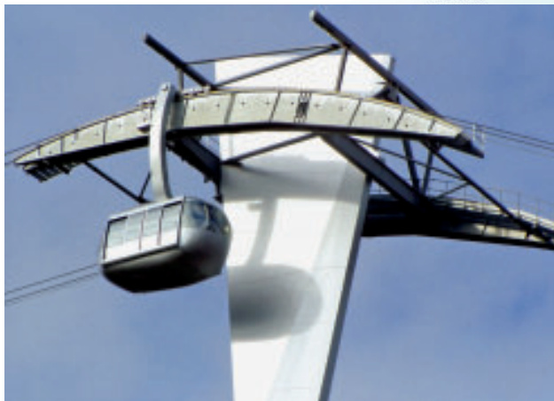
In die 55 m hohe Mittelstütze wurde eine Wartungsplattform integriert.
