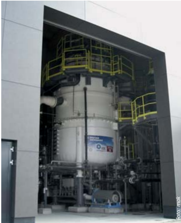
Der wetterunabhängige IDE Snowmaker direkt neben dem Talstationsgebäude der Pitz Panorambahn war Europas erste Schneeanlage nach dem Vakuumprinzip.
