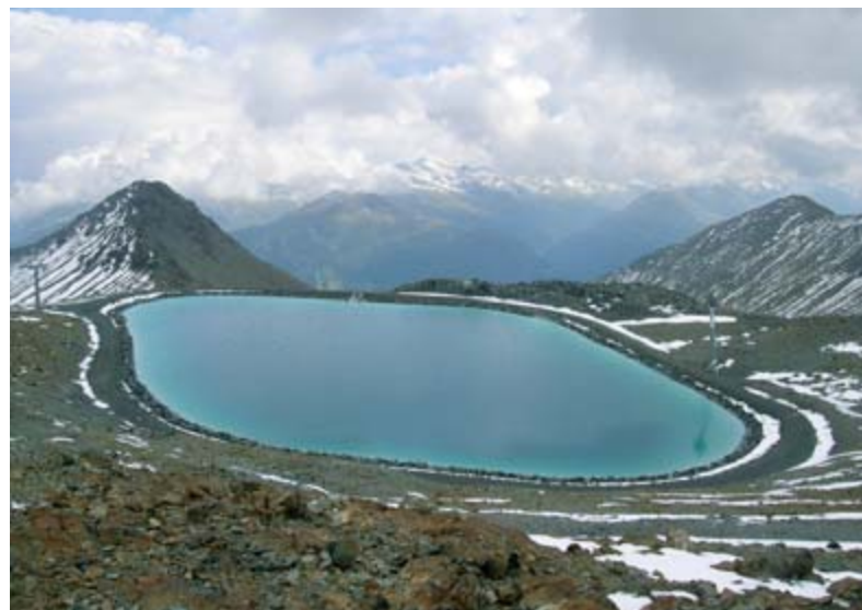
In der Region Davos entstand im letzten Jahr der vierte Speichersee für die Beschneigung. Der Speichersee auf der Totalp fasst rund 100 000 m 3 Wasser.
