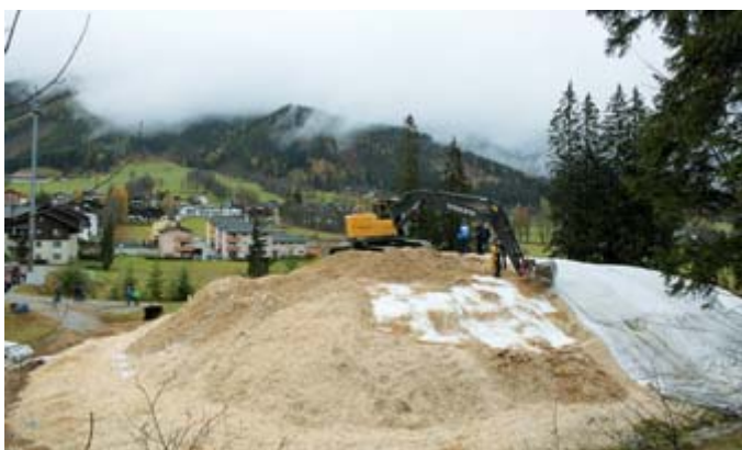
Die 20 Zentimeter dicke Hackschnittschicht beschützte rund 5 000 Kubikmeter Schnee über acht Monate hinweg.
