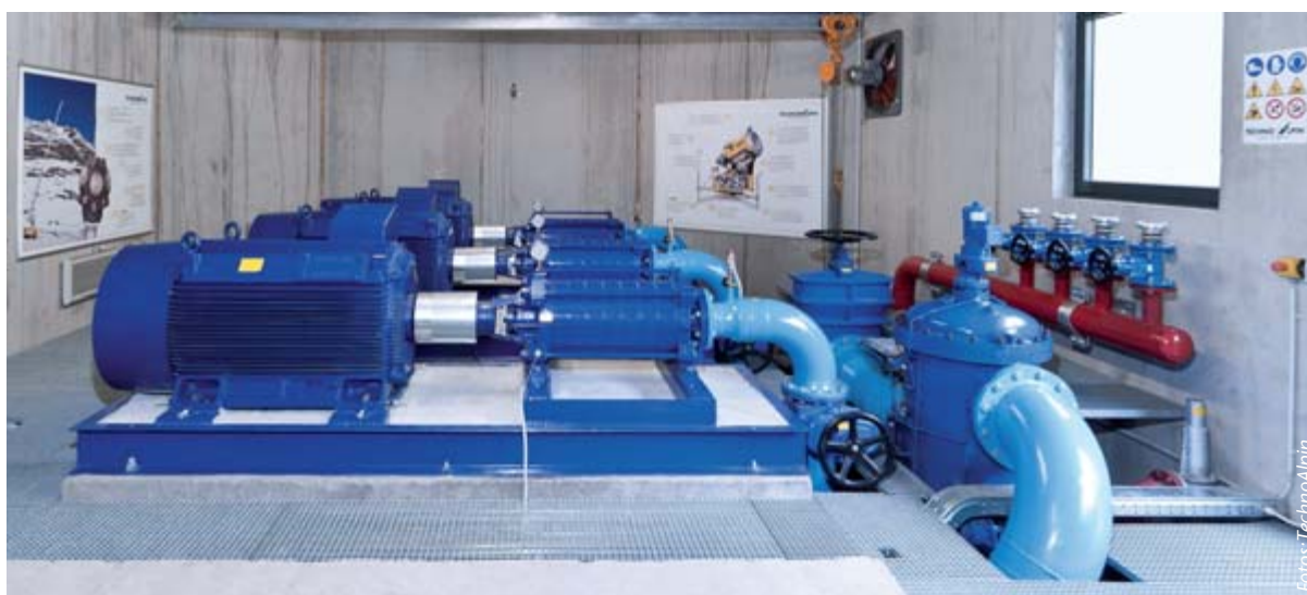
Pumpstation: Bei einer Beschneiungsanlage sind hohe Drücke gegeben. Eine detaillierte Analyse des hydraulischen Verhaltens gehört bei TechnoAlpin daher zum Standard, um die Betriebssicherheit der Anlage zu gewährleisten.
