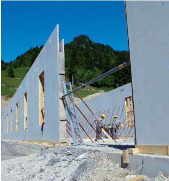
Der rückwärtige Teil der Sesselgarage wird später aufgeschüttet, sodass sie optisch im Berg verschwindet.
