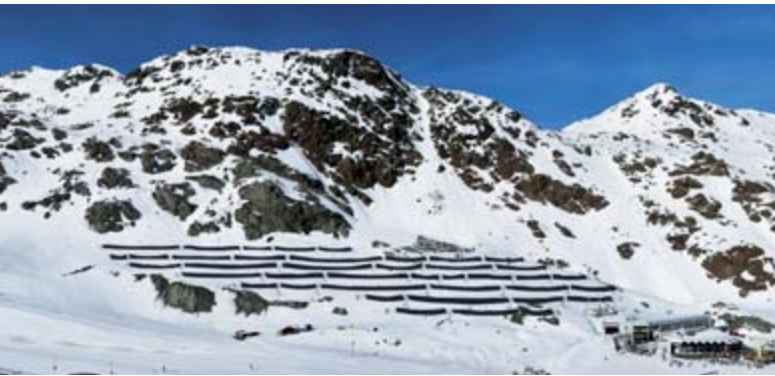
Die neue Photovoltaik-Anlage am Pitztaler Gletscher wird 2 500 PV-Module umfassen und ca. 850 000 kWh Strom pro Jahr liefern.
