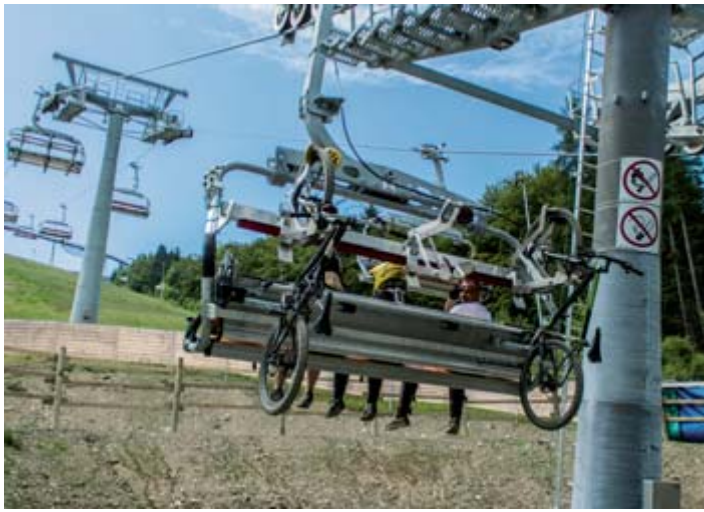
Im Sommer werden die 6er Sessel mit dem Mountainbike-Transportsystem von DOPPELMAYR ausgerüstet.
