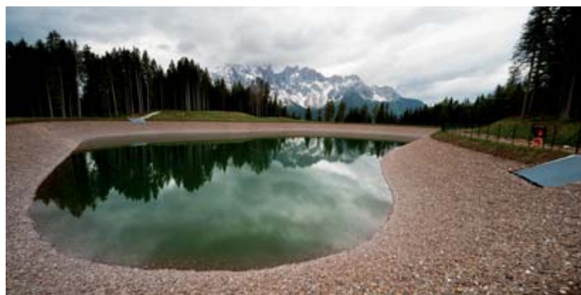
Speicher: Die Wasserversorgung ist einer der wichtigsten Aspekte bei der Planung einer Beschneiungsanlage. Schneiziele, Pistenoberfläche und auch künftige Ausbaustufen müssen berücksichtigt werden, um eine optimale Energiebilanz zu gewährleisten.
