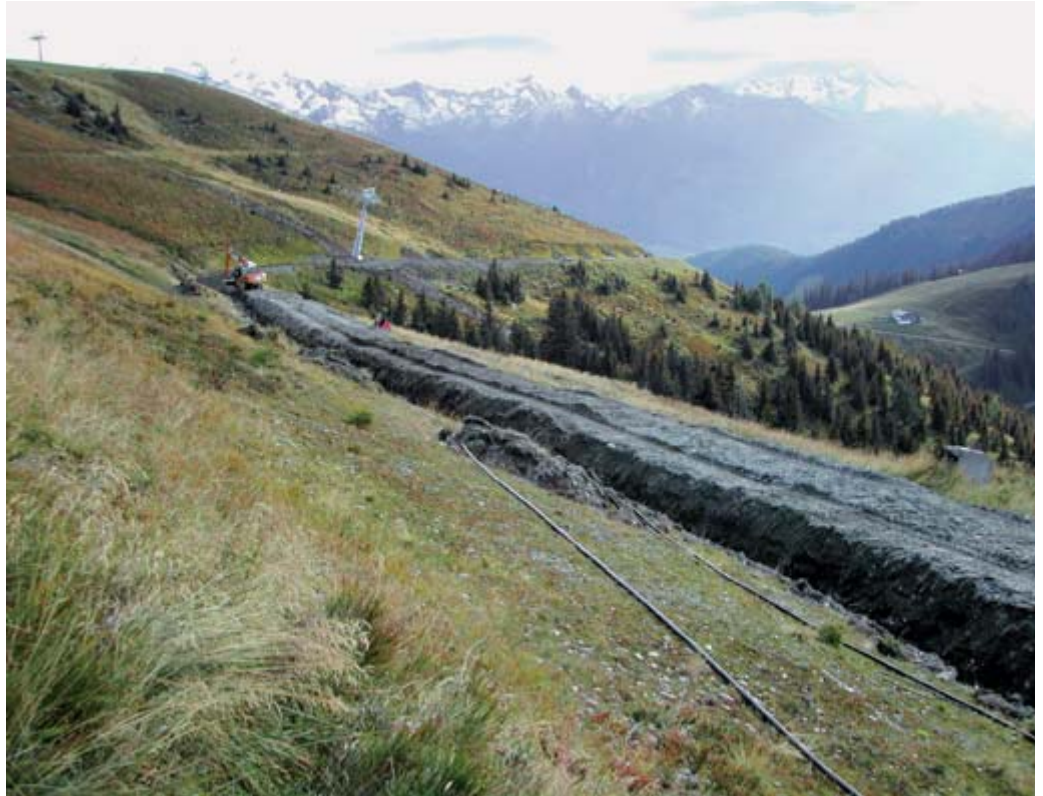
Im Skigebiet der Schmittenhöhebahn AG wurde mit der Erweiterung der BSA noch 2009 begonnen. Im Bild der Feldleitungsbau der Hahnkopfabfahrt. Foto: ILF
