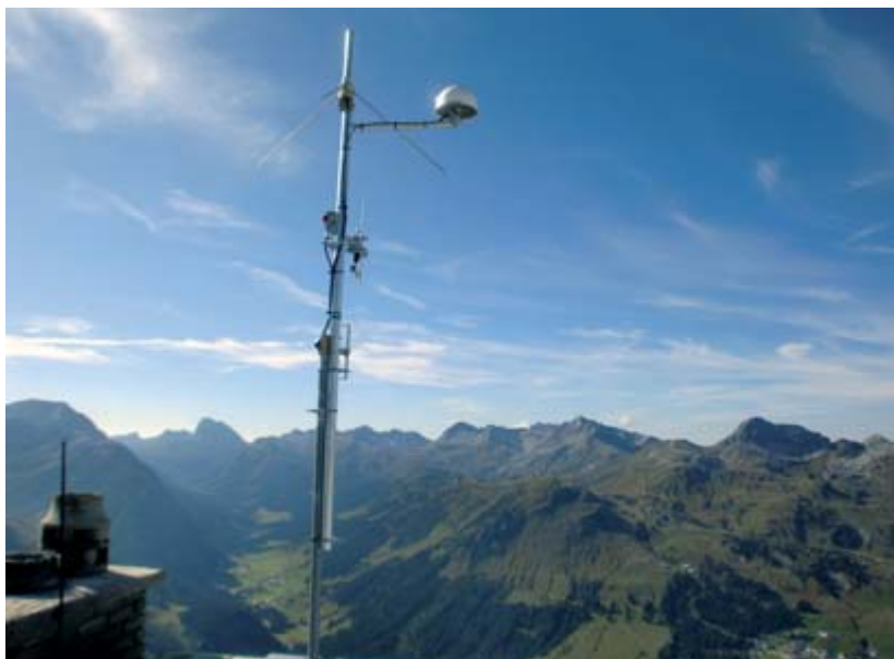
Die GPS Basisstation für das Pistenmanagementsystem der Skilifte Lech am Arlberg wurde am Rüfikopf errichtet, am Kriegerhorn ist ein zusätzlicher Repeater für das Korrektursignal positioniert. Foto: PowerGIS
