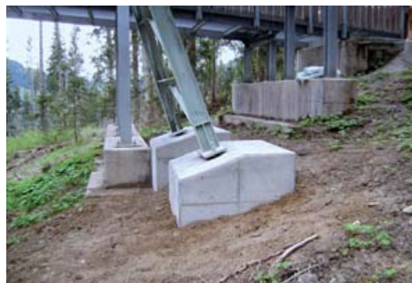
Schadhafte Stützenfunda- mente Hartkai- serbahn vor...
