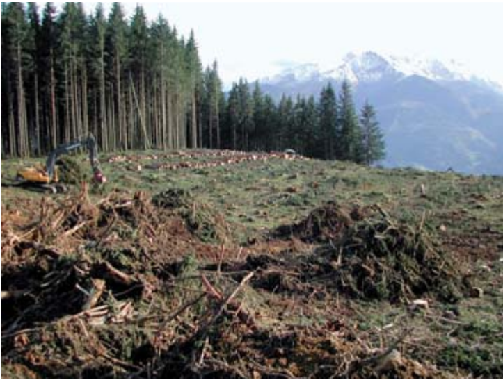
Die Baufeldfläche des Teiches ist wegen der Vollbestockung hier mit der Rodungsfläche identisch und beträgt 38 500 m 2 . Foto: Schmittenhöhebahn
