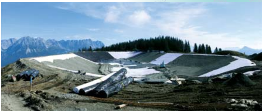
Folienverlegung durch IAT aus Weitensfeld.
