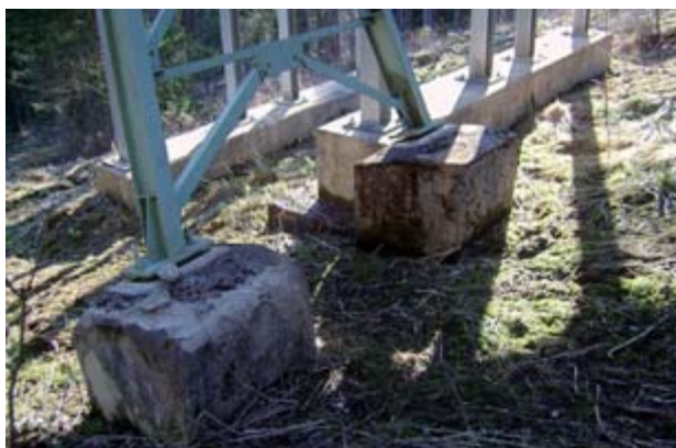
Schadhafte Stützenfunda- mente Hartkai- serbahn vor...
