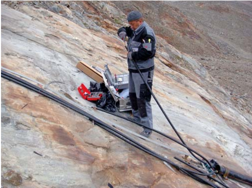
Willy Dengler bei HO Muffen im extrem steilen Gelände am Stubaier Gletscher. Fotos: Elektro Berchtold
