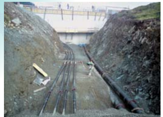
Entnahmeleitungen und Teich-Technik in Ellmau.
