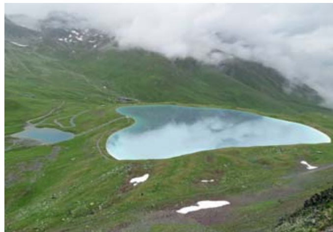
Beim Projekt für die Engadin St. Moritz Mountains ist der Bau des 400 000 m 3 fassenden Natur-Speichersees in 2 525 m Höhe das Herzstück des Konzeptes.
