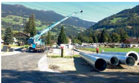
Die Teile der 25 m hohen Maste wurden von einem Schwerlastkran abgeladen und vor Ort zusammengebaut.
