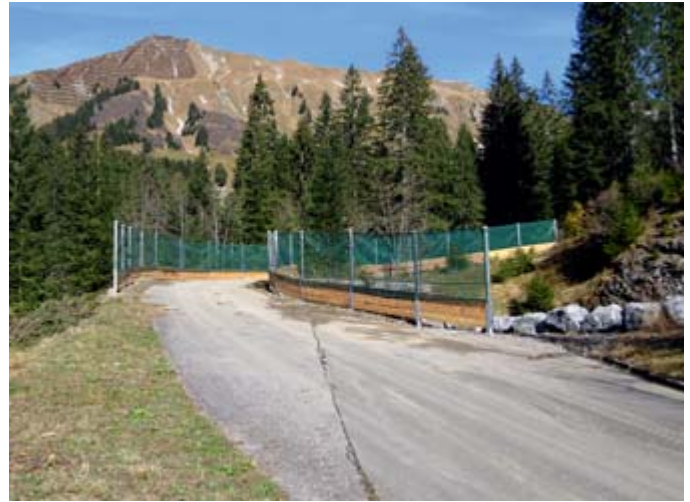
Eine Herausforderung war die Adaptierung eines alten Bundesstraßen-Stücks. Im Bild: Jumbo Sicherheits- u. Schneefangzaun von Meingast.
