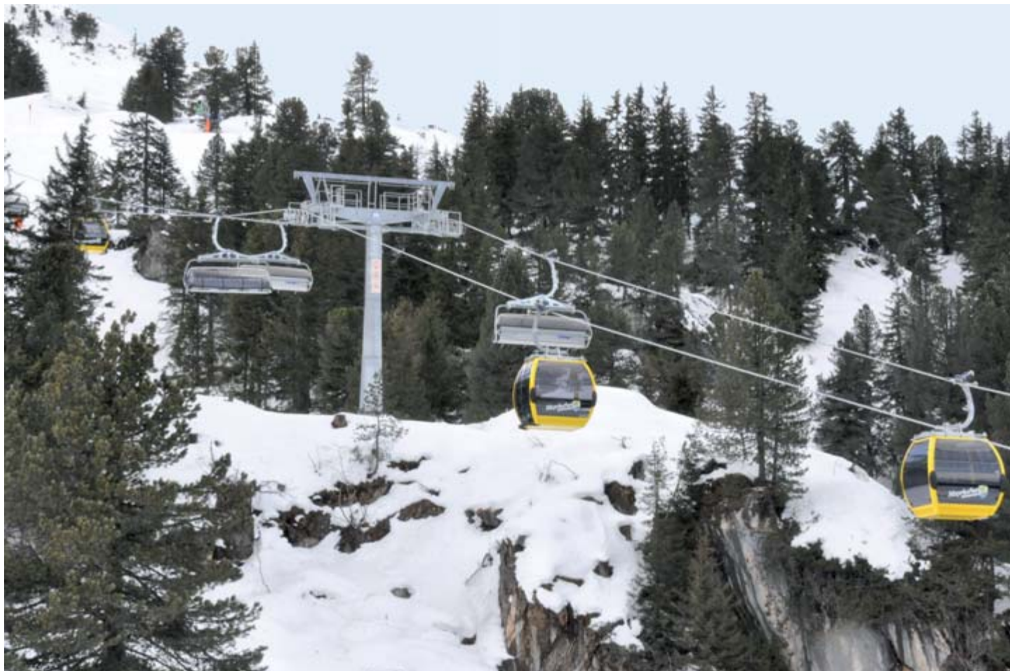
Die Kombibahn der Mayrhofner Bergbahnen AG verfügt über 10er-Kabinen und 8er-Sessel. Fotos: Mayrhofner Bergbahnen AG
