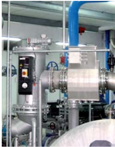
Kombination aus Rückspülfilter und UV-Entkeimung in der Station Jochstube neu in Scheffau.
