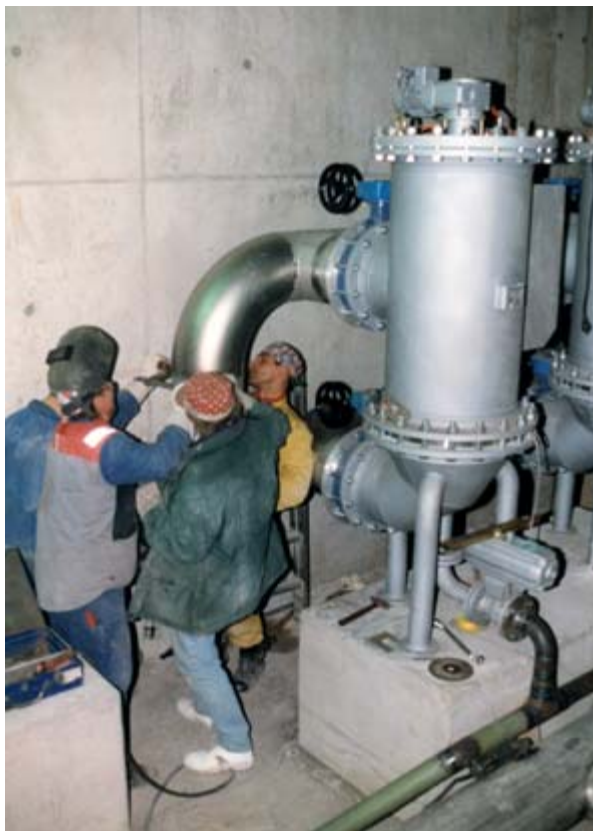
-AGB- Monteure beim Verrohren eines Filters. Auch große Dimensionen sind kein Problem für das -AGB- Montage-Team. Fotos: -AGB-
