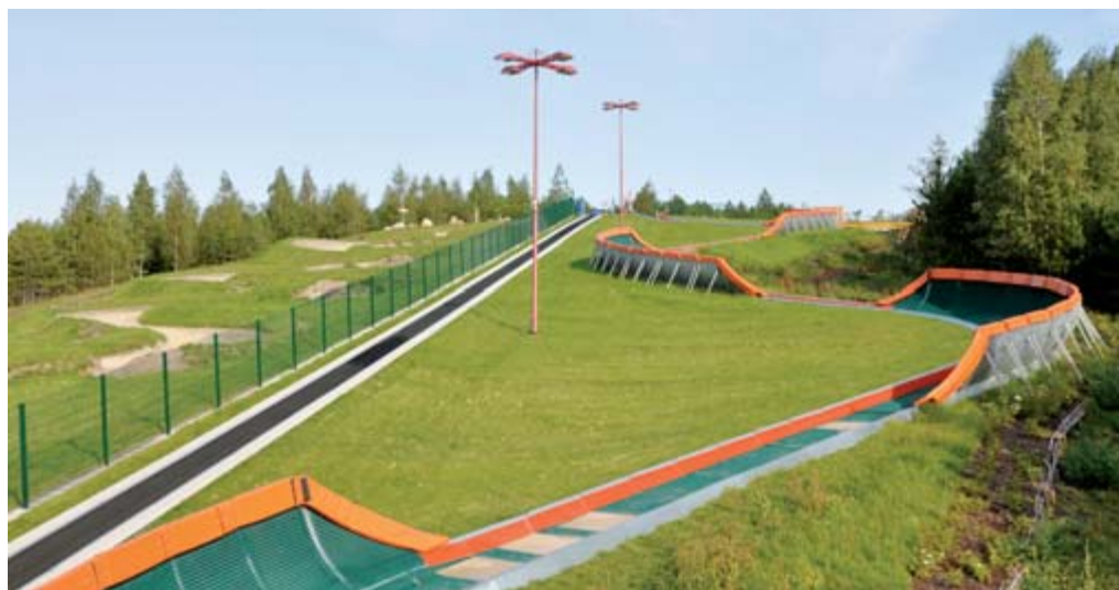
Der 106 m lange Zauberteppich dient als Aufstiegshilfe sowohl für die „Monsterroller“-anlage (l.) als auch für die 120 m lange Tubingbahn. Fotos: SunKid.
