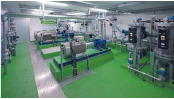
Die neue Pumpstation Läger ist bereits für die vierte Schneipumpe vorbereitet und beherbergt zusätzlich die 70-kW-Füllpumpe für den Speichersee Ischlag sowie den Zentral-Druckluftkompressor.
