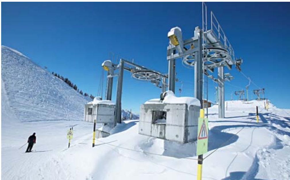
Für Förderseile im Seilbahnbereich übernimmt die Jakob AG gemeinsam mit nationalen Partnern die gesamte Logistik, einschließlich Ablegen des alten Seils, Seiltransport und Spleißarbeiten vor Ort.
