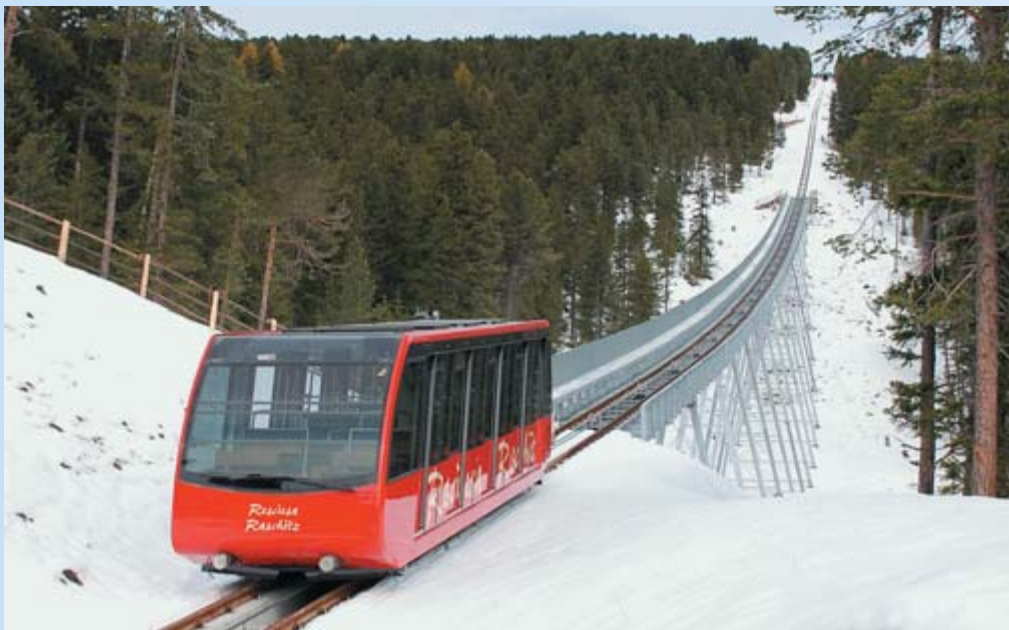
Die knapp 2400 m lange neue Raschötz-Bahn führt entlang des Naturparks Puez Ode. Die 280 m lange Stahlbrücke über den Taleinschnitt misst am höchsten Punkt etwa 20 Meter.
