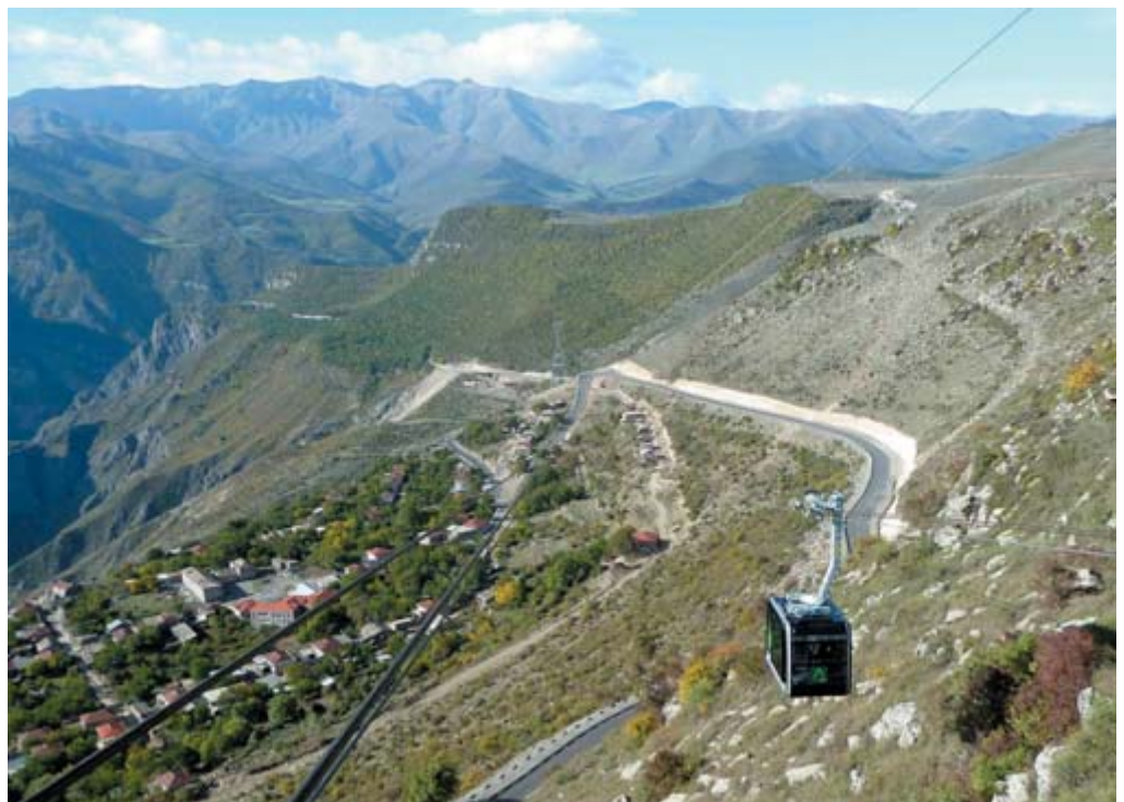
Noch ein Rekord: Mit der armenischen Anlage Halidzor-Tatev realisierte Garaventa 2010 die weltweit längste Pendelbahn in einer Sektion (schräge Länge: 5 765 m). Fotos: Garaventa AG, tb
