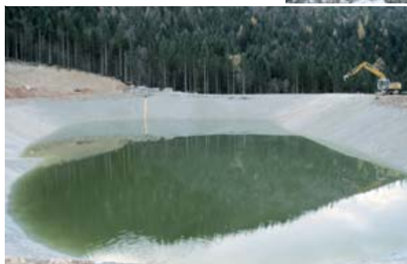
Der neue Speicherteich und eine neue Pumpstation mit einer Leistung von 3 x 70 l/sec sichern die Wasserzufuhr.
